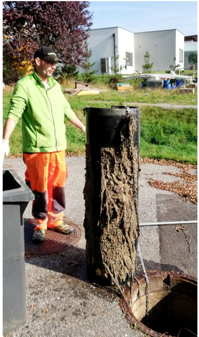
Foto: Klärwärter Karl Schachinger mit dem durch Feuchttücher... verstopften Grobfilter bei der Kläranlage Mörschwang.
